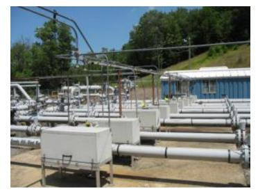
Figure 10. Example Meter Runs.
